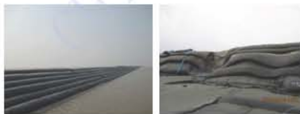
图 4 成型后的堤身断面 图 5 受影响破坏后的堤身
