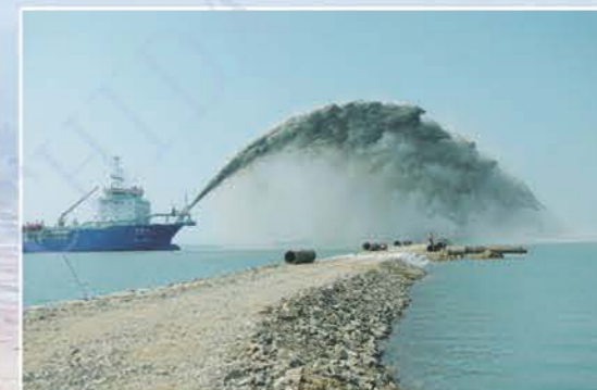
长江航道局承建的湄洲湾航道工程中艚吹施工
