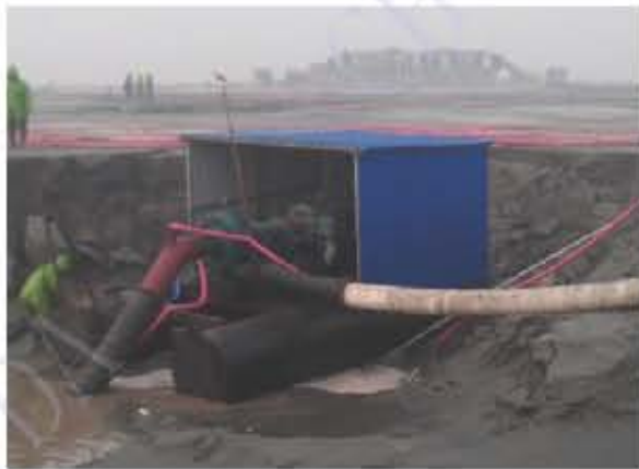
图 19 新型大功率泥浆泵取砂作业
