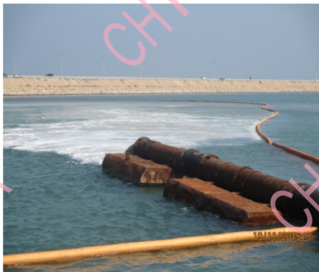
图5 防污帷幕封闭吹填区
