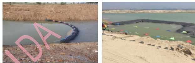
图 4 在排水明渠和排水口设置的防污帘
