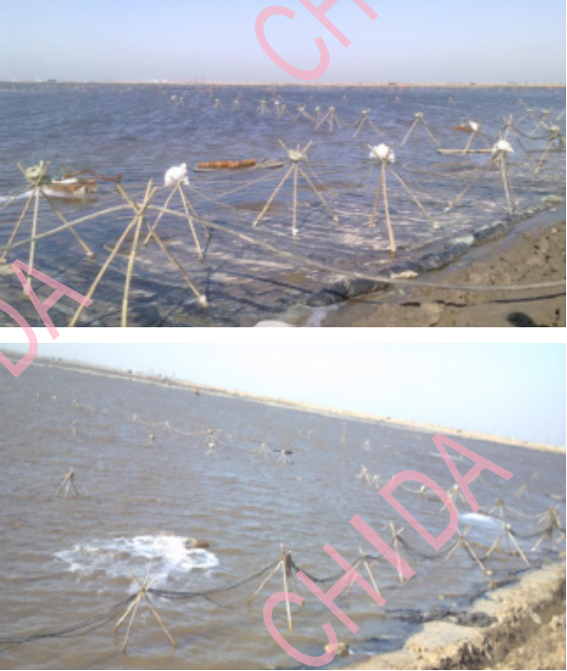
图 5 采用射流泵真空预压加固现场照片
