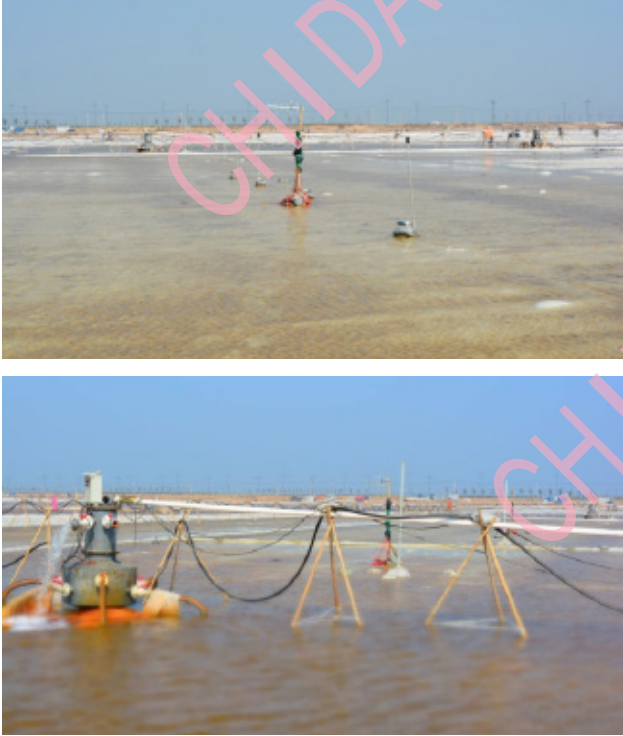
图 3 采用水气分离装置加固现场照片
