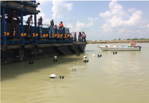
图 土工砂袋生产及抛填施工工艺
