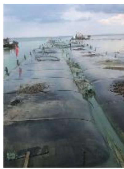
土工管袋堆场
